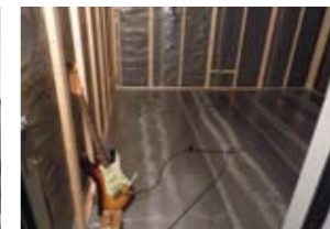
こだわりの防音室は、バンド仲間と音楽を思い切り楽しむための趣味の部屋(写真は完成前の防音室)。
